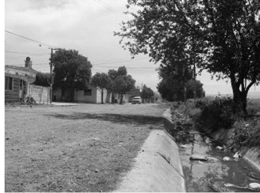
Abwasserkanal quer durchs Viertel.
